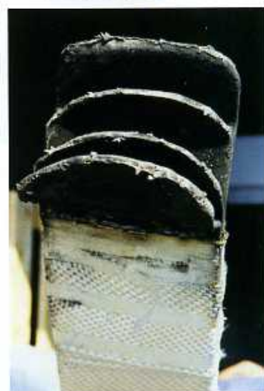
Figura 3.- Efectos del arco eléctrico (antes y después del corto).
